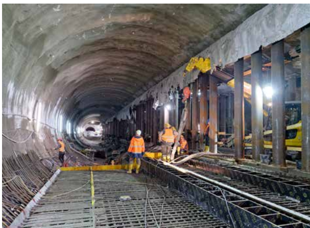
BAU DER INNENSCHALE in der Bahnsteigröhre Bahnhof Museumsinsel
