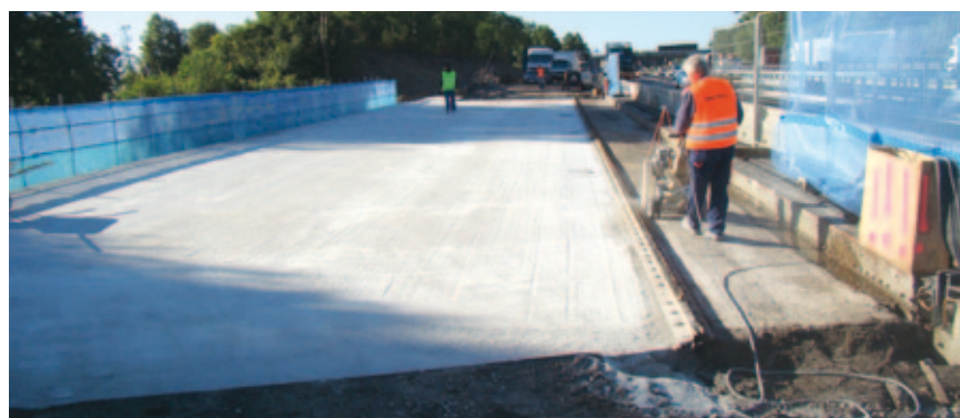
Abb. 7, Abbruch des Asphalts, der Kappen und der Abdichtung
