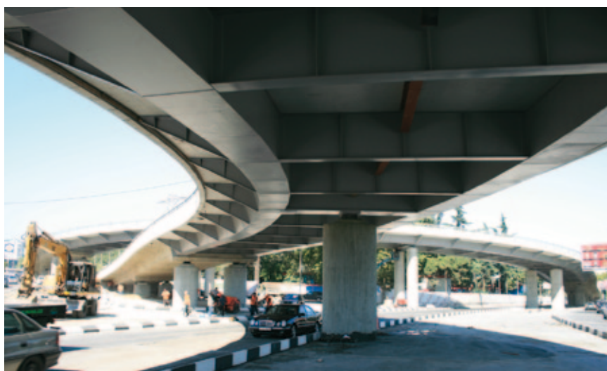
Abb.9, Laguna Bridge 02, Untersicht
