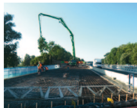
Abb.11, Einbau des Verstärkungsbetons
