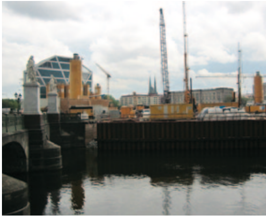
Abb. 11, Baustelle Bahnhof Museumsinsel
