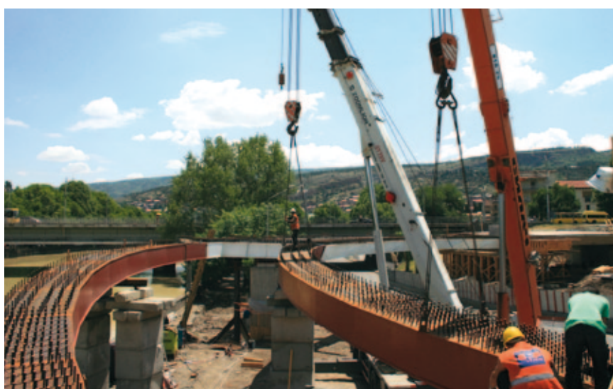
Abb.10, Laguna Bridge 01, Einheben eines Stahlträgers
