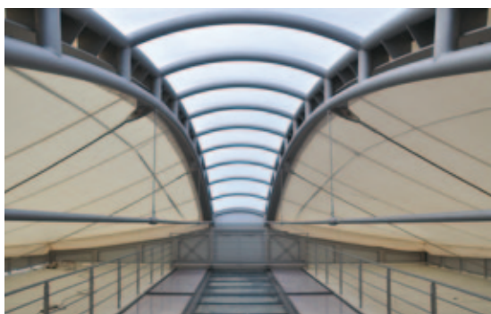
Abb.3, Zwischendach mit ETFE- und PTFE-Membranfeldern
