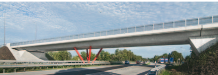
Abb.7, ABD Südbayern, BAB A 8 West, Überführung Lochhauser Straße in München
