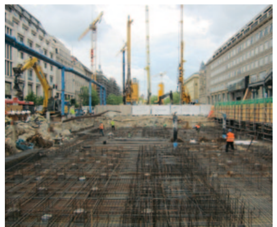
Abb. 12-14, Baustelle Bahnhof Unter den Linden
