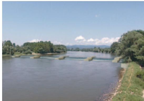
Abb. 5, Ein Wehr bei Aicha ist der wesentliche Unterschied zwischen Variante C 2,80 und Variante A. Dargestellt ist eine nur beispielhafte Visualisierung bei Mittelwasser. Aktuell beurteilt wurde ein Schlauchwehr mit vier Wehrfeldern und nur temporärer Wasserspiegelstützung.
