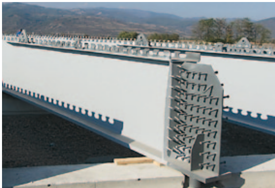
Abb. 12, Stahlträger auf der Baustelle; zweireihige Dübelbeiste im Auflager-/Rahmeneckbereich
