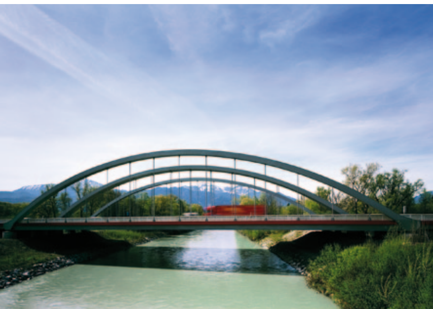
Abb. 13, ABD Südbayern, BAB A8 Ost, Brücke über die Tiroler Arche, Ansicht
