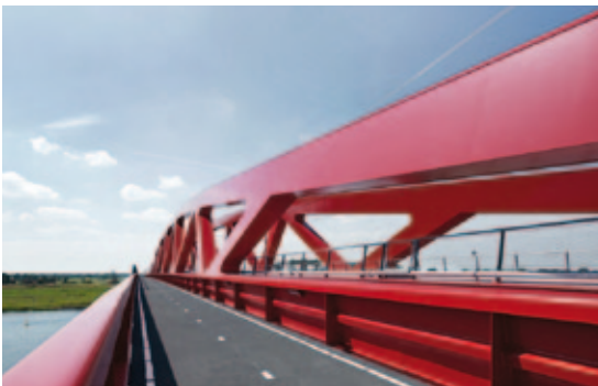
Abb.2, Brücke über die IJssel, Blick auf die Hauptöffnung über den Fluss IJssel mit einer Spannweite von 150 m; Brückengesamtlänge ca. 926 m
