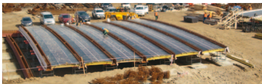
Abb. 3, Fertigungsplatz zum Betonieren der Fertigteile direkt neben der Baustelle
