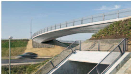
Abb.20-22, Stadt Augsburg, Brücken im Zuge der Anbindung des neuen Stadions
