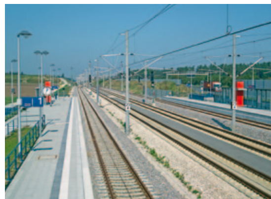
Abb. 1/2, NBS Nürnberg – Ingolstadt, Streckengleise in Fester Fahrbahn, Bahnhofsgleise mit Schotteroberbau, Streckentiefbau, Eisenbahnüberführung, Erd- und Dammbau, Personenverkehrsanlagen, Kabeltiefbau, Schallschutzwände, Stützbauwerke
