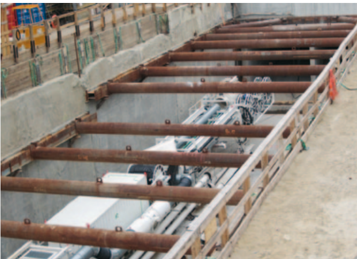
Abb.6, TVM unter der ausgesteiften GWA
