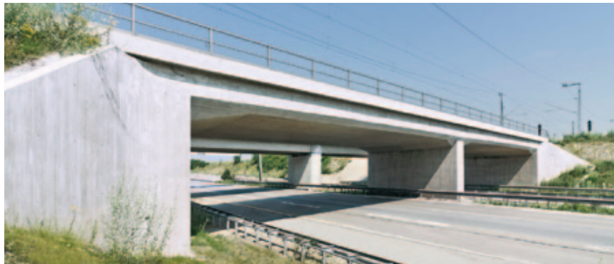
Abb.9, ABD Südbayern, BAB A8 West, Eisenbahnüberführung bei Gersthofen
