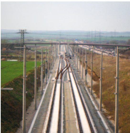
Abb. 5, FF Ilmenau – Erfurt, Weichenverbindung im Bau; Überleitverbindung, im Hintergrund einer von zwei Überholbahnhöfen, Gleislage Bf. in Schotterbauweise
