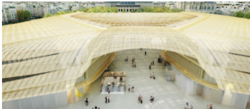
Abb.4, Perspektive mit Blick von schräg oben auf das Dach, links der Südflügel, rechts der Nordflügel und das Dach über dem Innenhof
