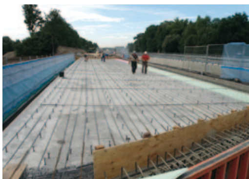
Abb.9, Einbau der Verbunddübel und der Bewehrung auf dem freigelegten Überbau
