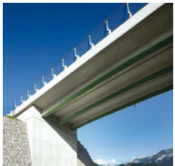
Abb. 14, Ansicht Brücke Kuchl;
