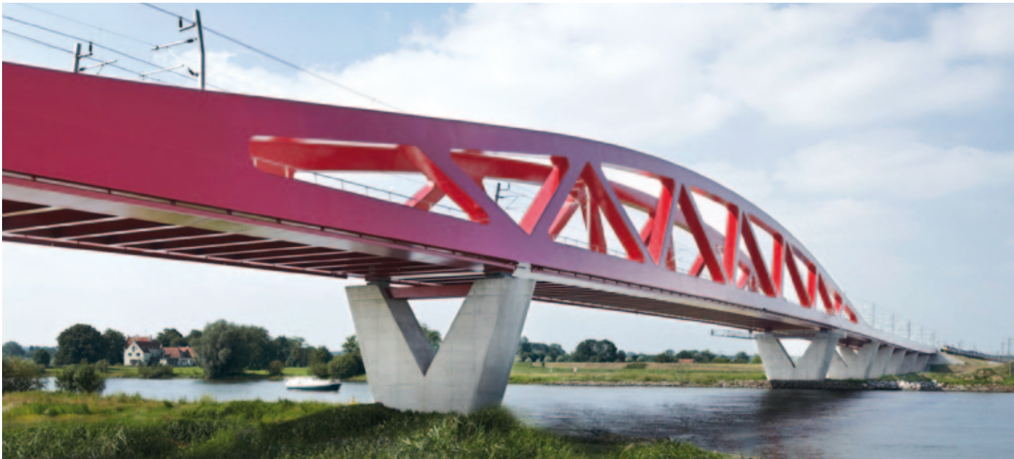
Abb.2, Brücke über die IJssel, Blick auf die Hauptöffnung über den Fluss IJssel mit einer Spannweite von 150 m; Brückengesamtlänge ca. 926 m
