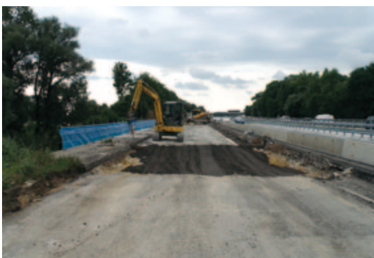
Abb. 6, Abbruch der Kappen und Abdichtung
