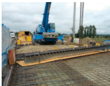
Abb.10, Einbau neuer Übergangskonstruktionen bei zwei Bauwerken
