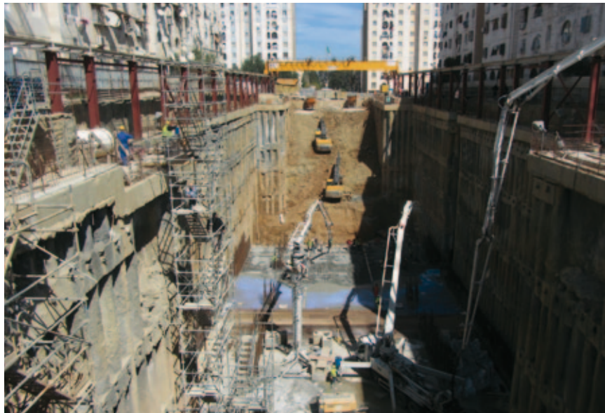
Abb.13, Endstation Ain Naadja 2 Bereich Ost, Betonieren der Bodenplatte
