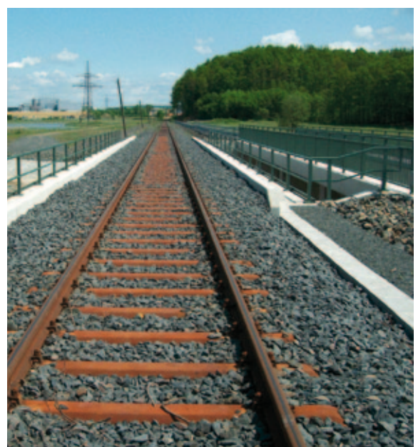
Abb.9/10, Hochwasserrückhaltebecken Goldbergsee, Blick auf die neu trassierte Strecke und den parallelen Weg, im Vordergrund die beiden Brücken
