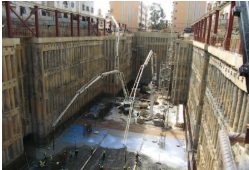
Abb.12, Endstation Ain Naadja 2 Bereich West, Betonieren der Bodenplatte
