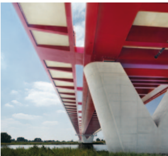
Abb.3/4, Brücke über die IJssel, Fußweg und Untersicht
