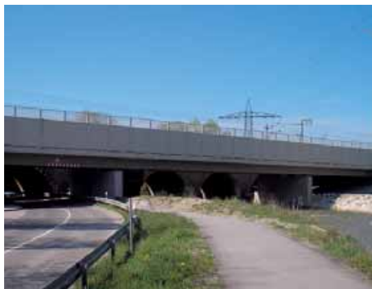
Eisenbahnbrücke im PB 6
