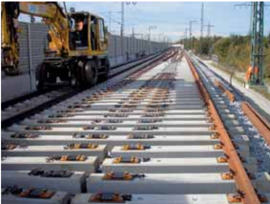
Gleisbau im PB 5 und 6
