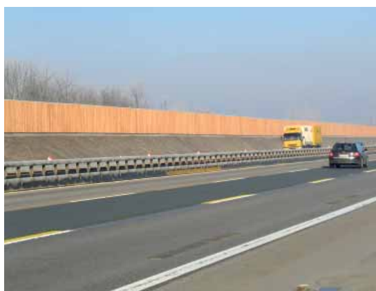
Betonwand mit Holzlattung auf Wall, A 9 / Bereich Garching und Eching
