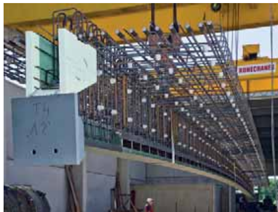
Der Stahlträger in der Betonierhalle
