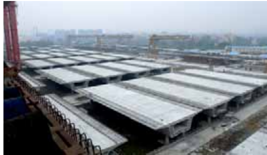
Fertigteilwerk 2: Wuhan – Guangzhou PDL DK 2203
