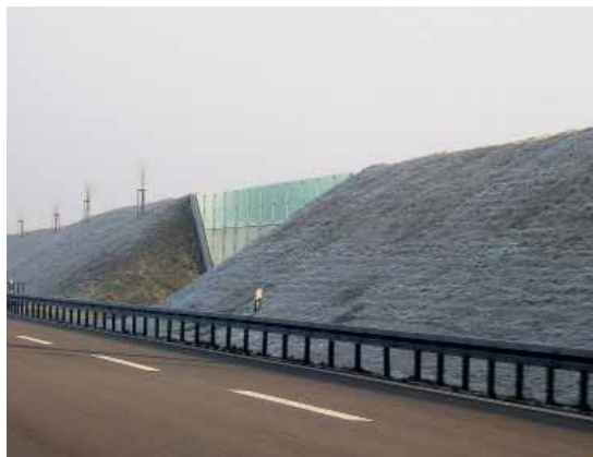
Lärmschutzbrücke mit punktgelagerter Planarverglasung, A9 / Unterführung Schleißheimer Kanal bei Garching
