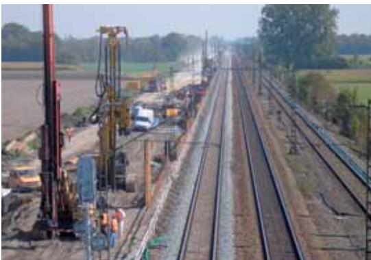
Verbreiterung Bahnkörper im PB 5 und 6
