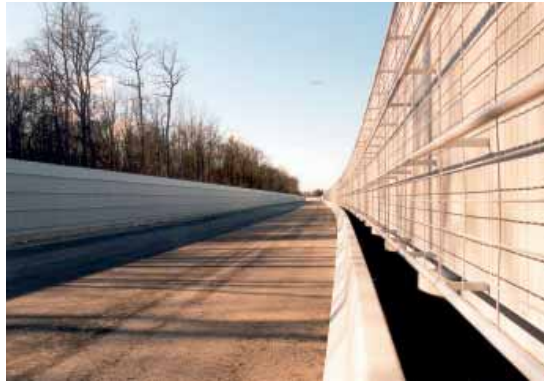
Betonwand mit Aluminium-Vorsatz- schalen, A 99 / Allach
