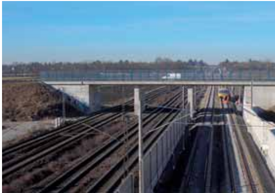
Straßenbrücke im PB 6
