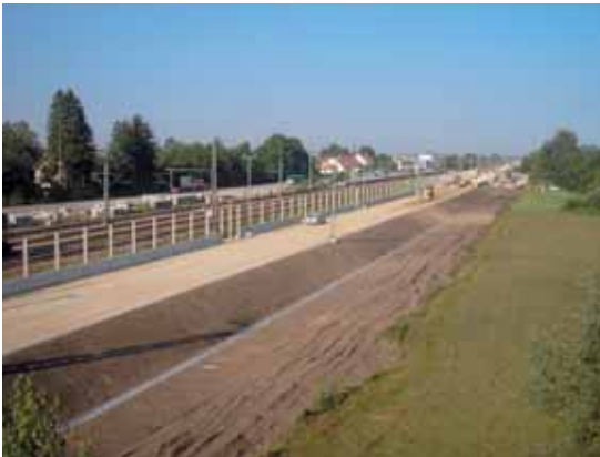
Vorbereitung Bahnkörper im PB 5 und 6
