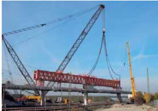
Rückbau einer Straßenüberführung im PB 6
