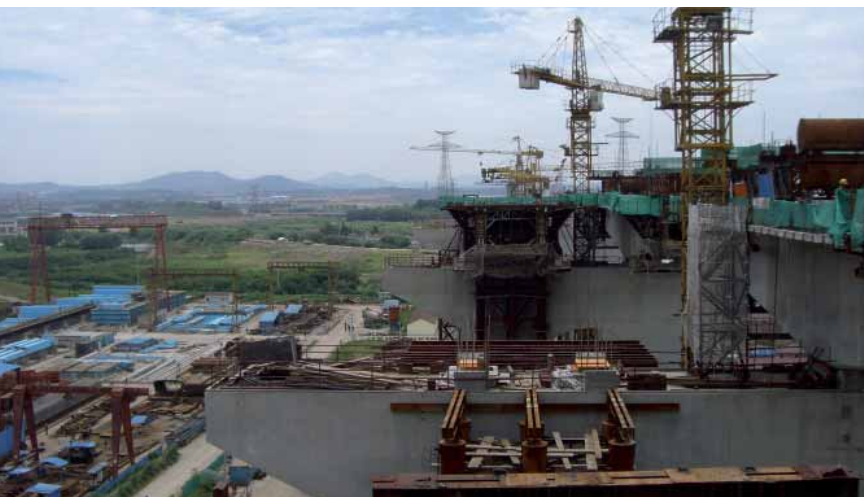
Nanjing Big Bridge, Blick auf Vorlandbrücken und Lagerplatz
