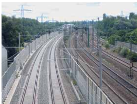
Schallschutz- und Stützwände im PB 5 und 6
