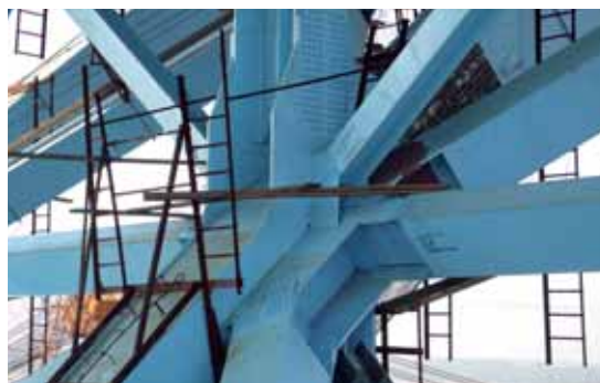
Fachwerkknoten NBB mit Schraubverbindungen
