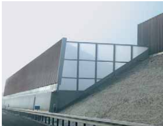
Transparentes Querschott an einem breiten Unter- führungsbauwerk, A 9 / Garching – Unter- führung der B 471
