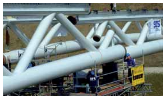
Einheben des Mittelteils
