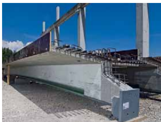
VFT-WIB-Träger im Fertigteilwerk
