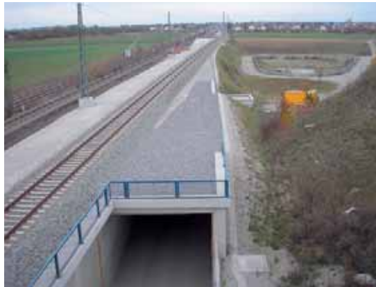
Überführungsbauwerk im PB 6
