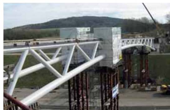
Verschweißen der Bauteile im Schutz einer Einhausung
