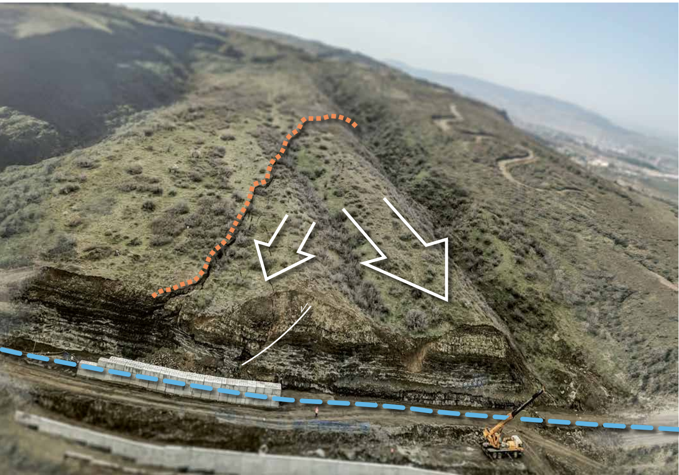
Geländebefund nach dem ersten Ortstermin. Eine wichtige Wasserversorgungsleitung wird durch die Felsgleitung direkt bedroht.
