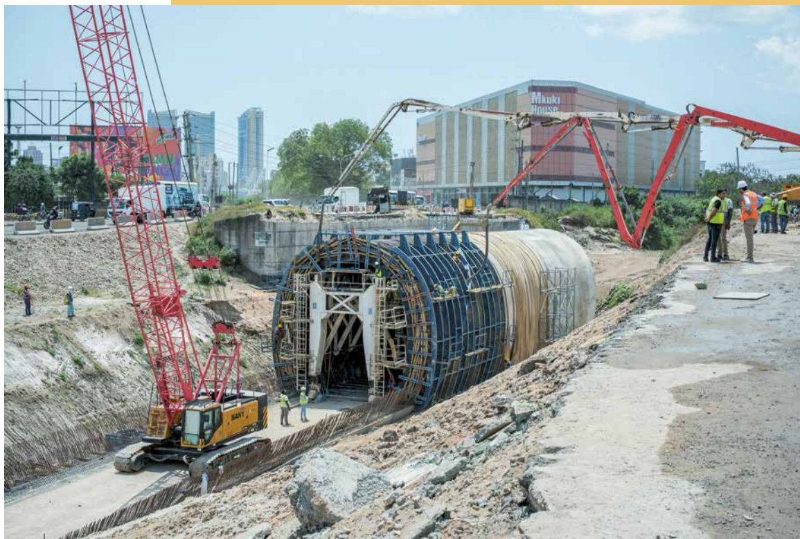
Überführung der Meterspurbahn in Daessalam.
