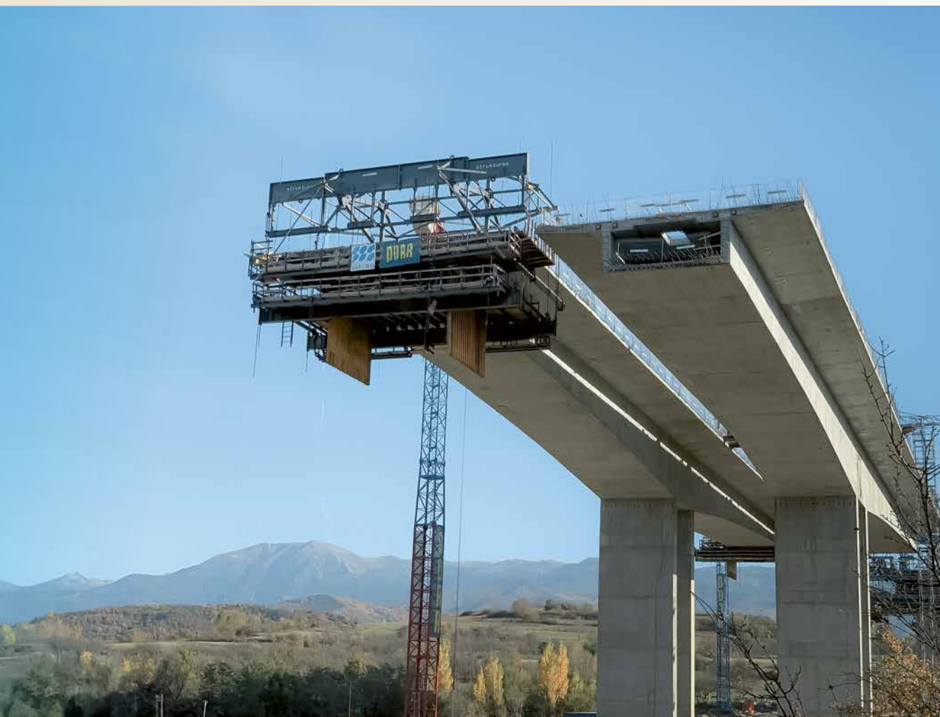
Spannbetonbrücke im Freivorbau.
