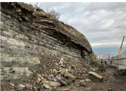
An der Rutschungsfront zeigen sich Bewegungen im Meterbereich sowie sekundär abplatzende Steine und Blöcke.
