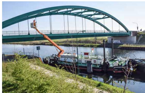
Bild rechts: Straßenbrücke Horster Damm über den Elbe-Lübeck-Kanal in Lauenburg – Prüfung mit Brückenuntersuchungsschiff der WSV.
