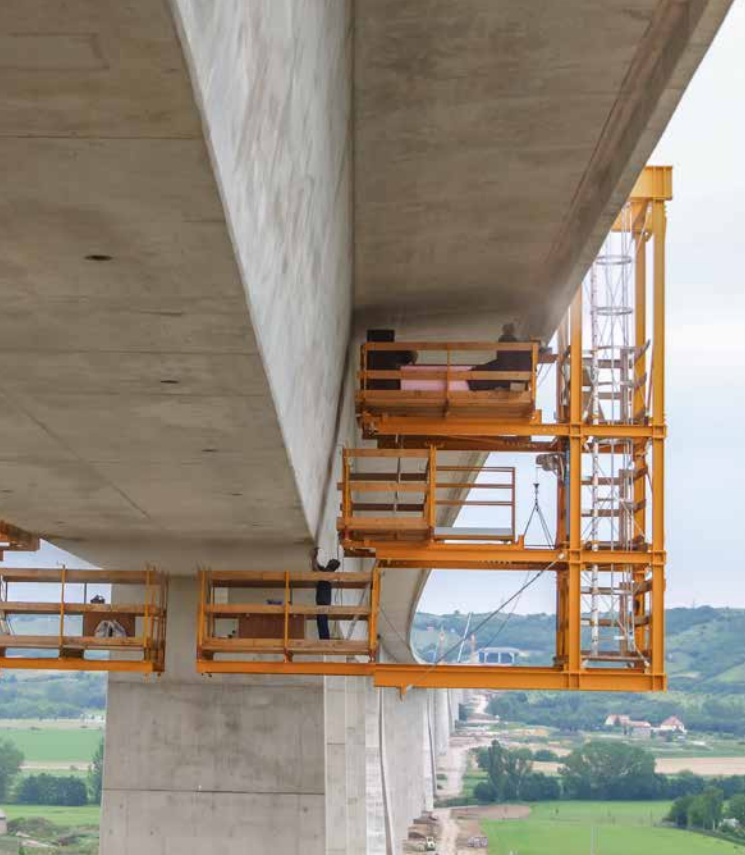
Bild links/Mitte: Unstruttalbrücke Karsdorf, NBS Erfurt – Halle/Leipzig – Prüfung der Unterbauten mit Steiger und des Überbaus mit Verschrüstung.
