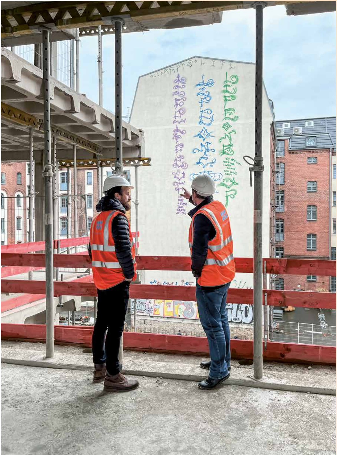
Die SSF Mitarbeitenden David Nieter (links) und Constantin Kaaz (rechts) begutachten den Baufortschritt.
