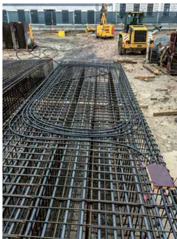
Thermische Aktivierung Schlitzwandlamelle.
