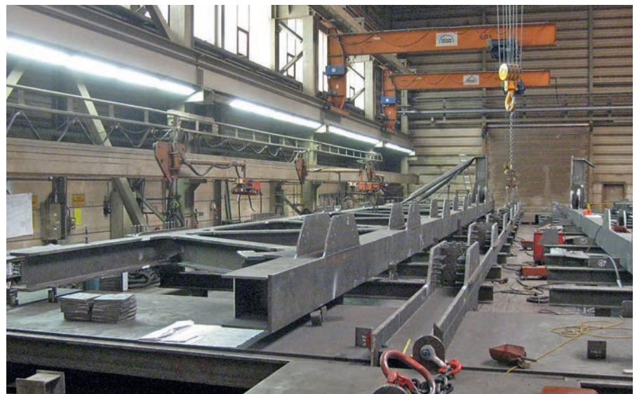
Bild 19. Werkstattfertigung der Stahlfachwerkscheiben
