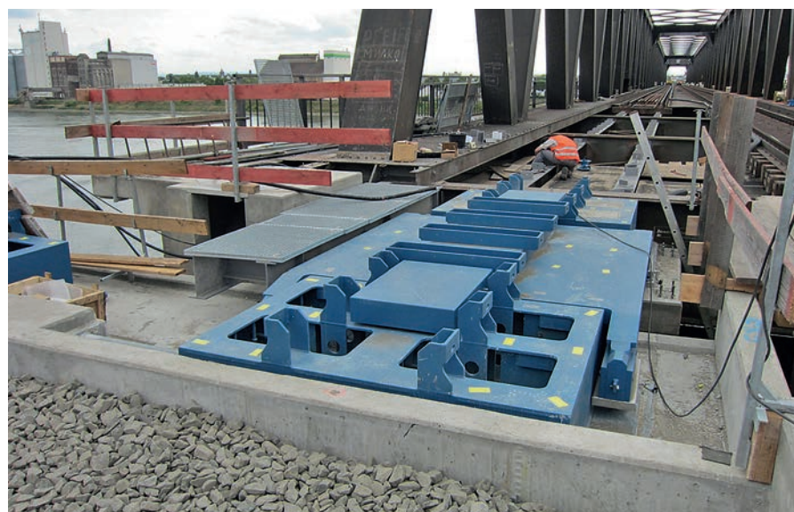
Bild 13. Installierte Ausgleichsplatte mit Verankerungsblöcken Fig. 13. Installed compensation plate with anchoring blocks
