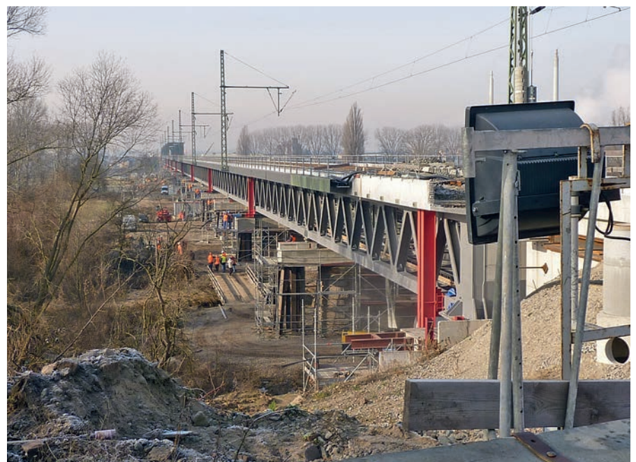
Bild 21. Querverschub des Bauwerks Fig. 21. Displacement of the construction
