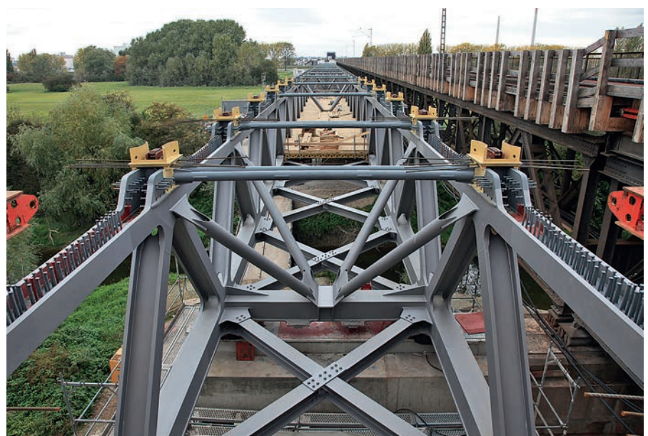
Bild 23. Stahltragwerk im Bauzustand Fig. 23. Steel structure in construction phase
