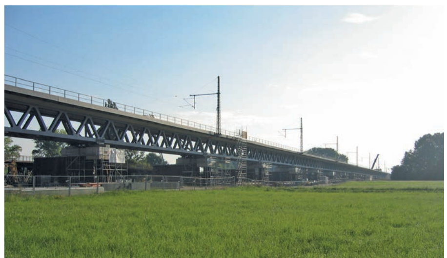
Bild 1. Ansicht der neuen Brücke Fig. 1. View of the new bridge
