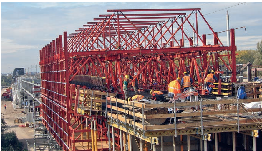
Bild 18. Installierter Schalwagen für Herstellung Fahrbahnplatte Fig. 18. Installed formwork wagon for manufacturing of the reinforced concrete superstructure
