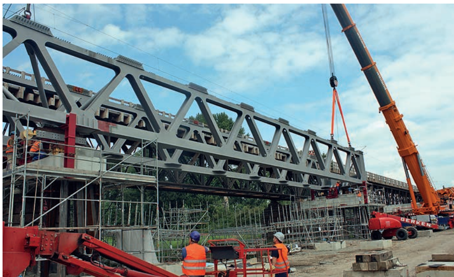
Bild 17. Hubmontage der Stahlfachwerkträger Fig. 17. Elevated installation of the steel framework girder
