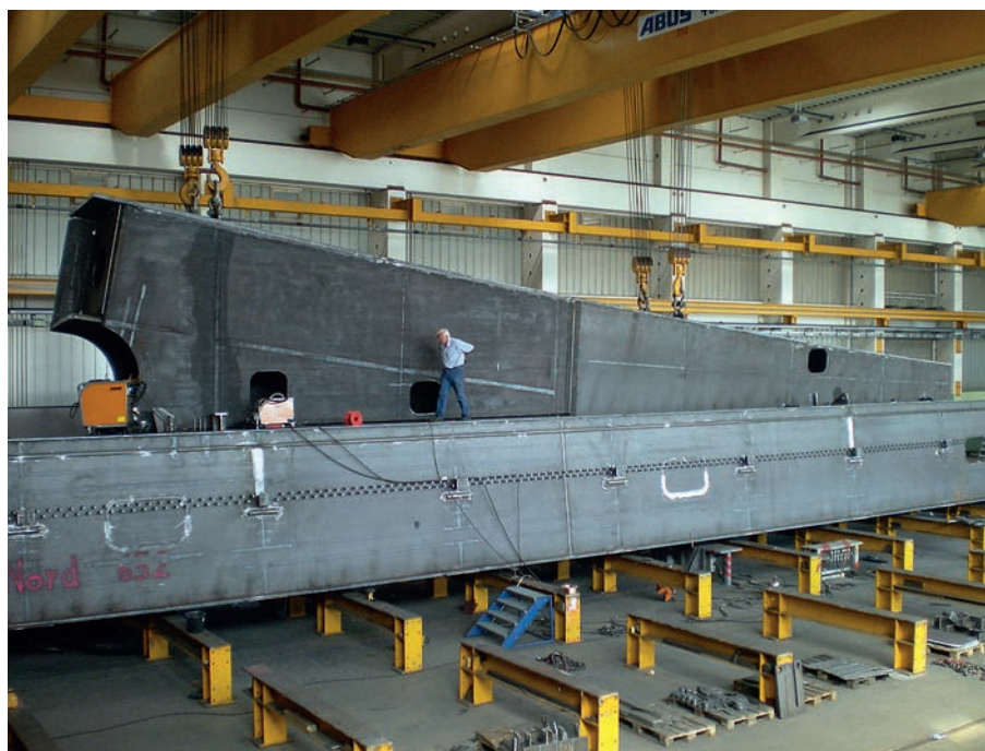
Bild 12. Fertigung im Werk Fig. 12. Assembly in the plant
