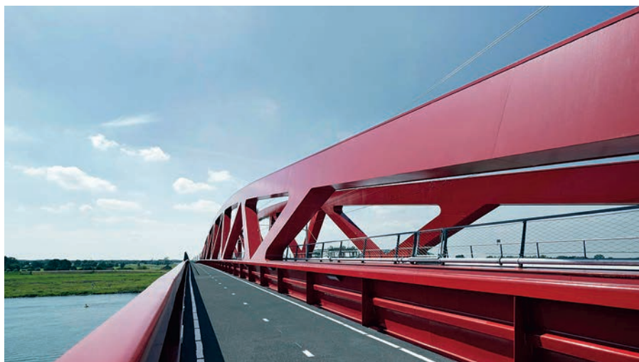
Bild 16. Der Rad- und Fußweg getragen vom weit gespannten Fachwerkbogen Fig. 16. Cycle way supported of the arched structure
