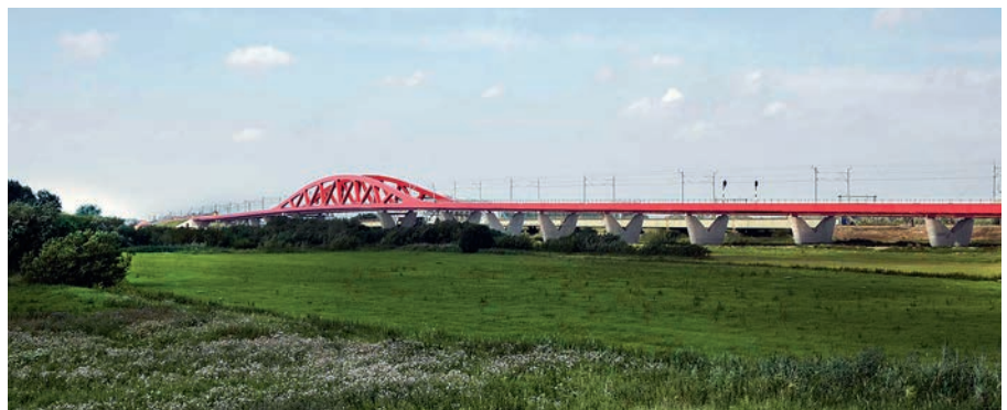
Bild 8. Gesamtansicht des Brückenbauwerkes Fig. 8. General view of the bridge
