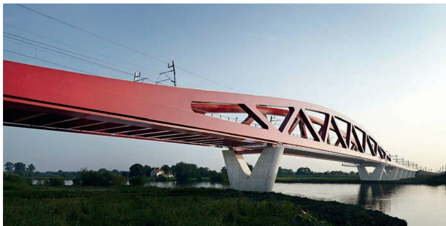
Bild 17. Die Eisenbahnüberführung im Einklang mit der ebenen Flusslandschaft Fig. 17. The railway structure beeing in line with the landscape
