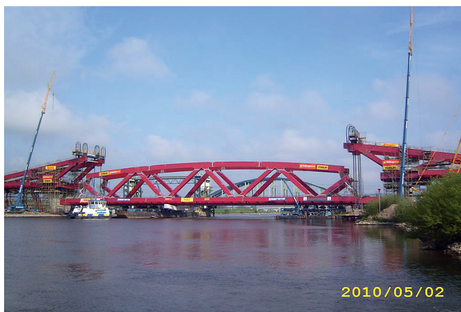
Bild 14. Gesamtansicht Litzenhub Fig. 14. General view of the lifting
