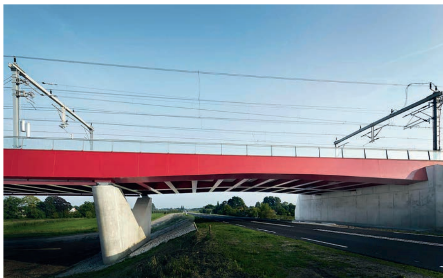
Bild 9. Überführung über den Gelderse Dijk Fig. 9. Bridge over the Gelderse Dijk
