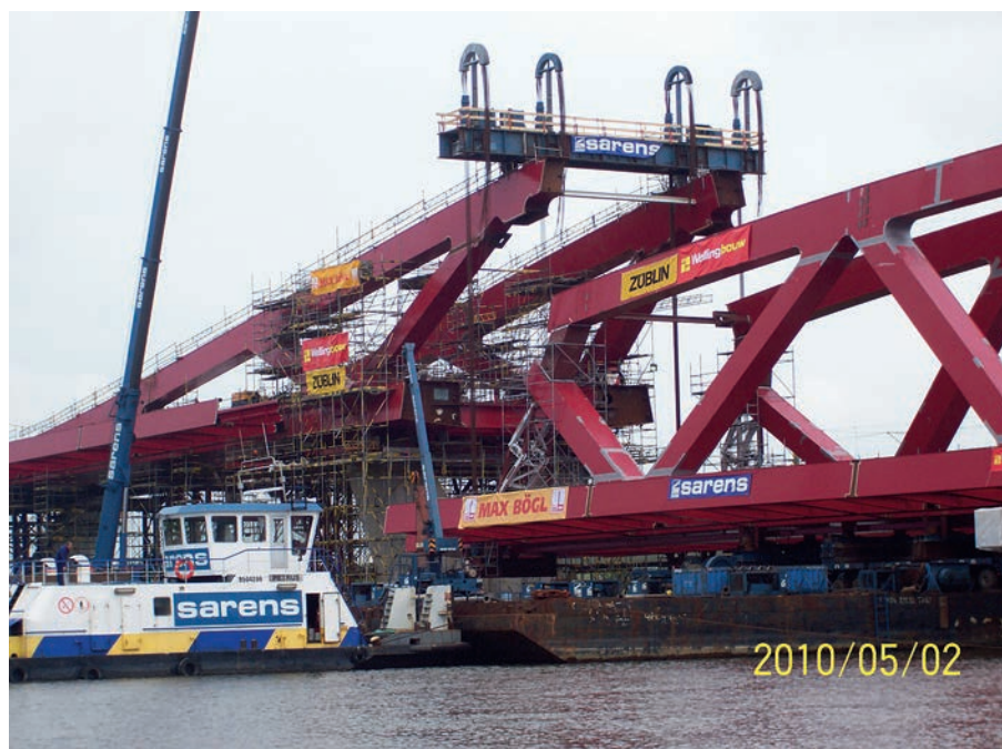
Bild 13. Detailansicht Litzenhub Fig. 13. Details of lifting
