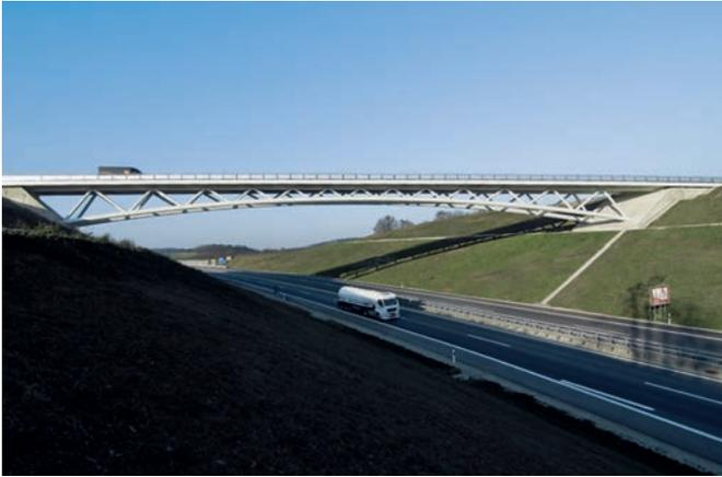
**Bild 5** Ansicht der integralen Rohrfachwerkbrücke
