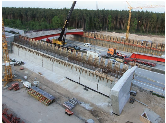
Bild 6 Trägermontage Mounting of girders
