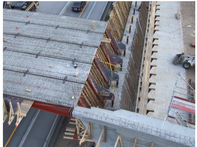
Bild 5 Rahmenwand und Auflager Frame wall and bearings
