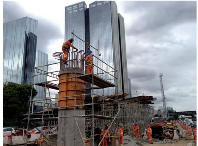
Bild 7 Pfeilerherstellung Achse 50 in beengter Insellage vor der Skyline des „Complexo JK“. Im Hintergrund Betonierabschnitt 1 mit einer Länge von 61,15 m über knapp 2 Felder Pile construction axis 50 in confined “island position” in front of the skyline of “Complexo JK”. Visible in the background superstructure concreting section 1 with a length of 61.15 m over almost 2 spans
