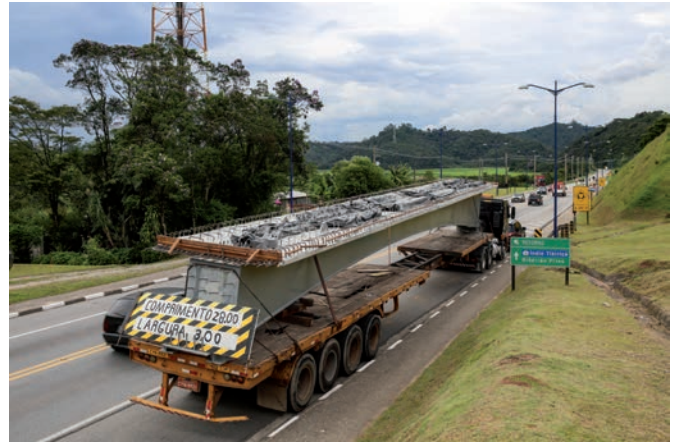
Bild 16 VFT-Träger – Transport. VFT-Träger für Achse 20-30; Transportlänge 22,20 m, Gewicht 32 t VFT® girder transport. VFT® girder for axis 20-30; transport length 22.20 m, weight 32 t
