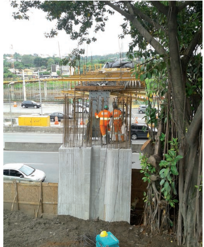
Bild 20 Blick vom Parque do Povo Richtung Westen auf die Widerlagerbas-tion Achse 10. Überbau in VFT-Bauweise bereits verlegt View from Parque do Povo in direction west onto abutment axis 10. Superstructure in VFT® construction method already placed
