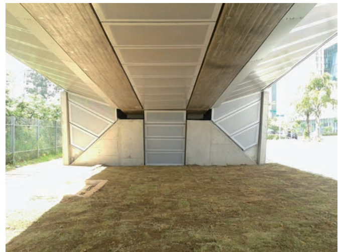
Bild 21 Blick Richtung Osten auf Frontseite Widerlager in Achse 10 – Av. Kubitschek; teilweise fertiggestellte Lochblechverkleidung View in direction east onto front side of abutment in axis 10 – Av. Kubitschek; partially completed perforated plate sheeting
