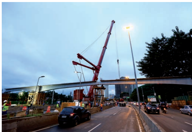
Bild 18 Blick Richtung Norden Avenida das Nações Unidas auf verlegten Überbau. Trägerhälften der Autobahnquerung mittig auf Hilfsgerüst abgestapelt. Vorbereitungsarbeiten für den Abbau des Mobilkrans am Ende der nächtlichen Sperrung – 21./22. März; Sonntag morgen 6.30 Uhr: Via Local bereits für Verkehr wieder geöffnet View in direction north onto Avenida das Nações Unidas onto placed superstructure. Girder halves of highway crossing stacked onto temporary scaffolding. Preparatory phase for demounting of mobile crane at the end of the nightly close-off – March 21/22; Sunday morning 6.30am: Via Local already reopened to traffic
