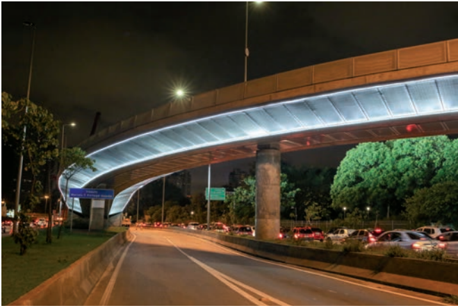
Bild 11 Samstag, 21. März 2014: Blick Richtung Norden. Beleuchtung der fast fertigen Viaduto. Fahrspuren der untenliegenden Via Central als auch des Viaduto bereits gesperrt für Aufbau Mobilkran (nächtliches Einheben der VFT-Träger der Passarela in Gesamtsperrepause) Saturday, March 21, 2014: View in direction north. Lighting of the almost completed viaduto. Lanes of underneath lying Via Central as well as the viaduto already closed off for mobile crane assembly (nightly mounting of VFT® girders of the passarela during complete road closure)
