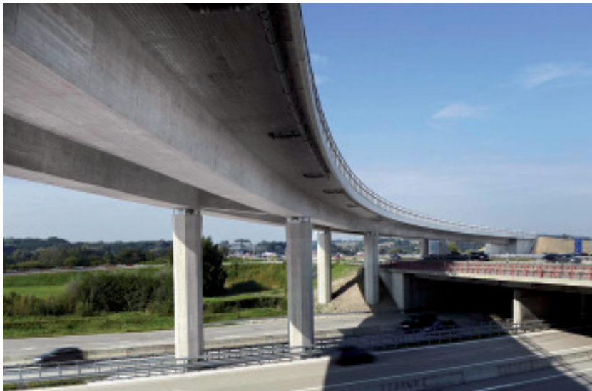
Bild 2. Überbauansicht des fertigen Bauwerks Fig. 2. General view of the superstructure
