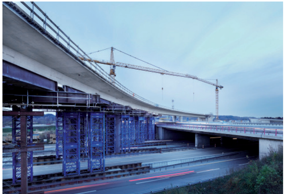
Bild 8. Überbauansicht nach dem Ausschalen des 2. Bauabschnittes Fig. 8. General view of the superstructure after stripping of formwork of the 2 nd construction section
