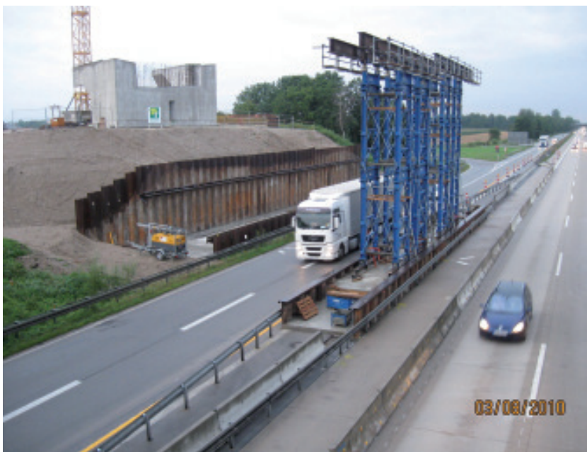
Bild 4. Zwischenunterstützung im Trennstreifen der Fahrbahnen Fig. 4. Supporting structure between the lanes of the motorway
