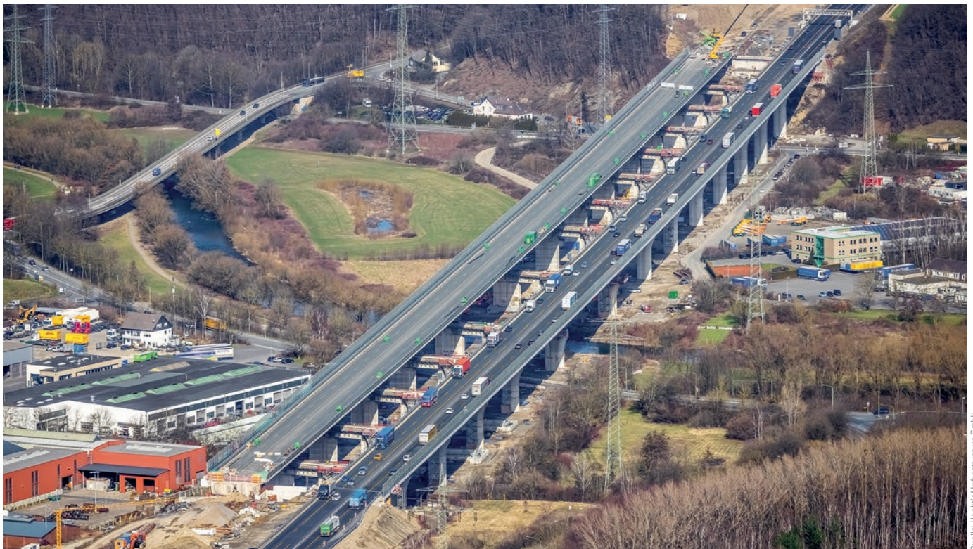
Bild 12 Luftaufnahme der Lennetalbrücke vor dem Querverschub Aerial view of the Lennetal bridge before the transverse sliding
