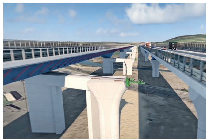
Bild 5 Visualisierung des Zustands vor Beginn des Querverschubs Visualisation of the situation before the start of the transverse sliding
