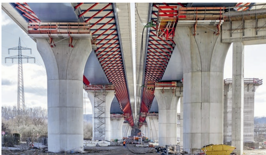
Bild 13 Untersicht der Lennetalbrücke kurz vor Verschubende Bottom view of the Lennetal bridge shortly before the end of transverse sliding
