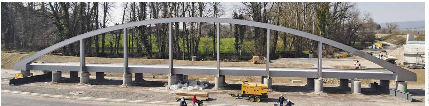
Bild 7 Fertig montiertes Stahltragwerk von BW21 vor dem Einheben in Endlage Completed steel structure of BW21 before lifting in place
