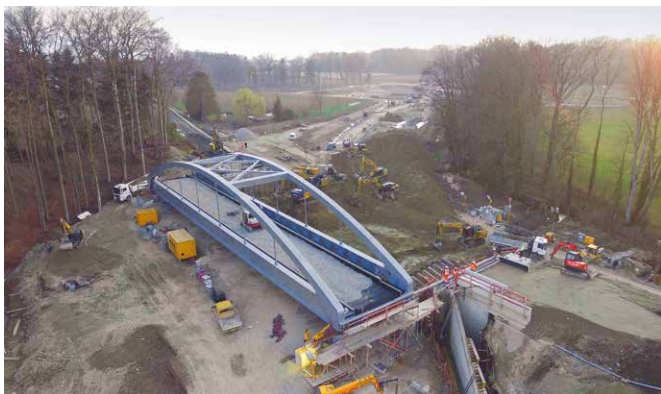
Bild 9 Einschub des Überbaus von BW04 in der Sperrpause der Bahnstrecke Moving the superstructure of BW04 in place
