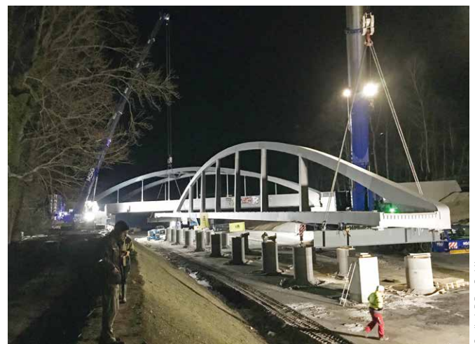
Bild 11 Einheben von BW21 in Endlage Lifting BW21 in place
