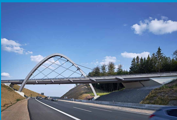
Monobogen / Überführung der St 2312 über die A3 Brückenlänge 108,30 m Stahlverbundbauweise
