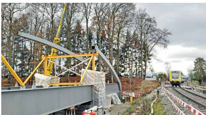
Bild 10 Überbaumontage von BW04 neben der Bahnstrecke Assembly of the superstructure of BW04 beneath the railway line
