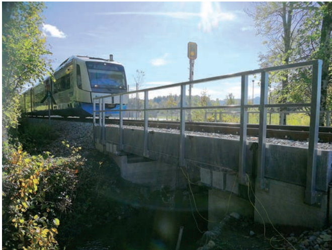
Bild 8 Eisenbahnbrücke EÜ Dürnbach während Messungen im Betrieb Railway bridge EÜ Dürnbach during measurements in operation
