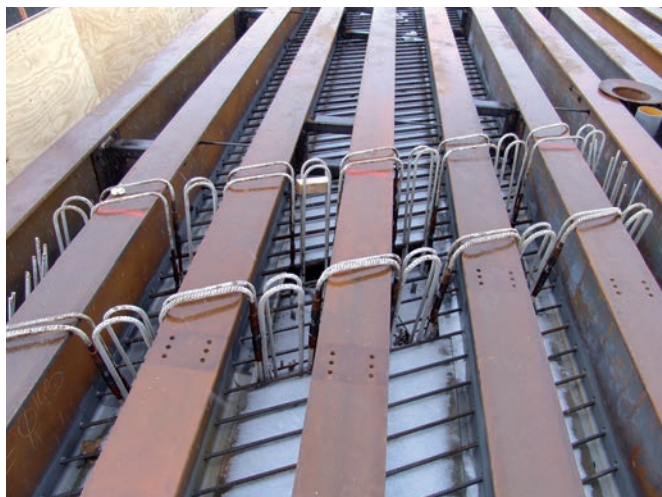
Bild 10 Verlegen der Bewehrung auf der Baustelle Installation of reinforcement in site
