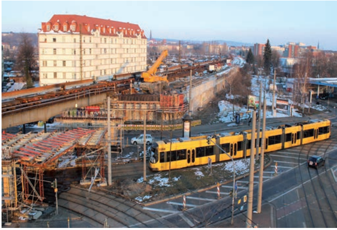
Bild 12 Baudurchführung unter Verkehr Construction under traffic
