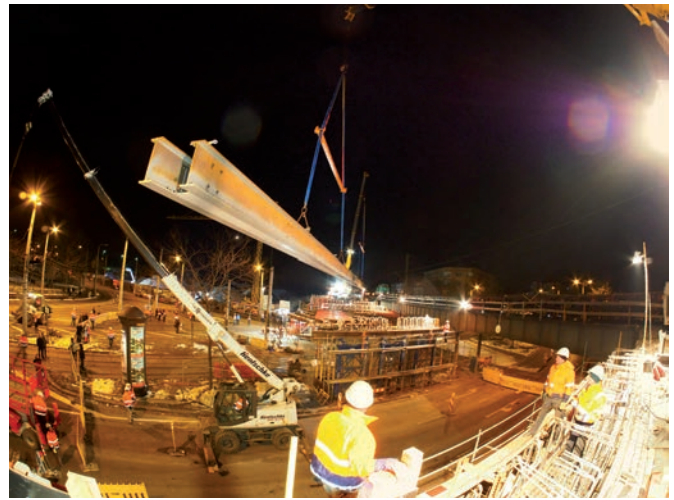
Bild 14 Verlegen der Walzträger Installation of the rolled iron girders
