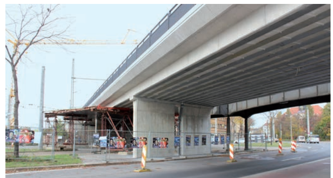
Bild 1 Gesamtansicht neues Bauwerk Overall view of the new bridge
