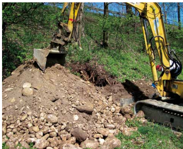
Baggerschurf am Bestandsdamm der Autobahn
