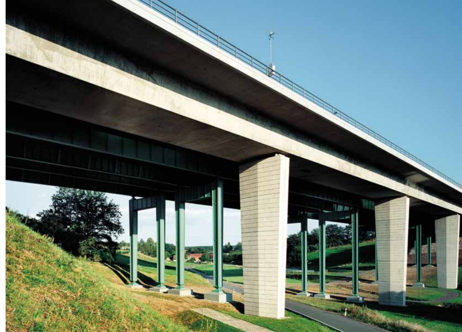
Ansicht West des Brückenneubaus
