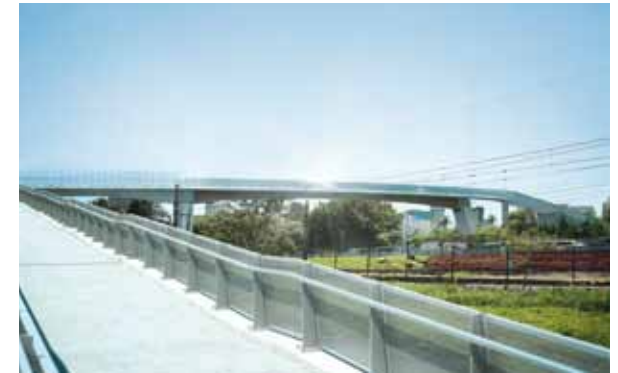
Die Fußgänger- und Fahrradbrücke zwischen dem Parco de Povo in Sao Paulo über die Stadtautobahn Marginal Pinheiros und die Metro zum Flußufer des Pinheiros-Flusses. Dies ist das erste Brückenbauwerk in Brasilien in VFT-Bauweise.
