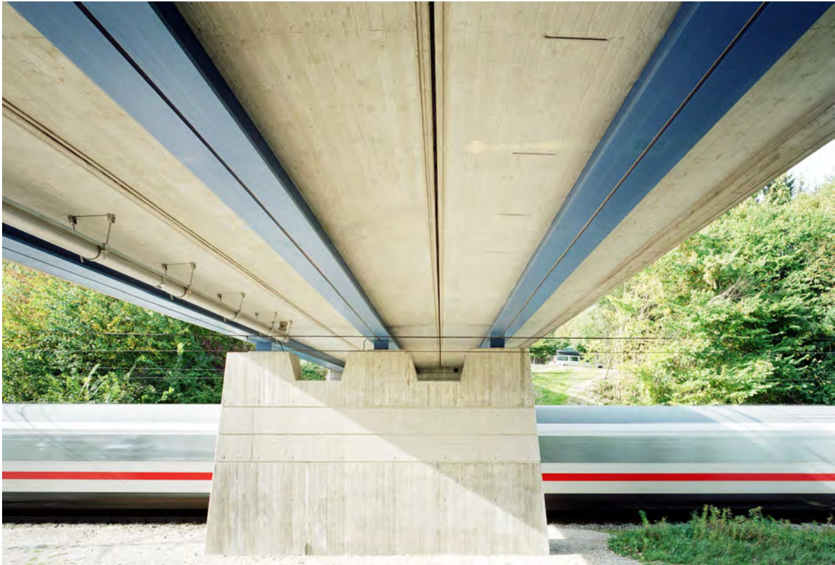
Abbildung 4: Untersicht der Straßenbrücke in Pöcking
