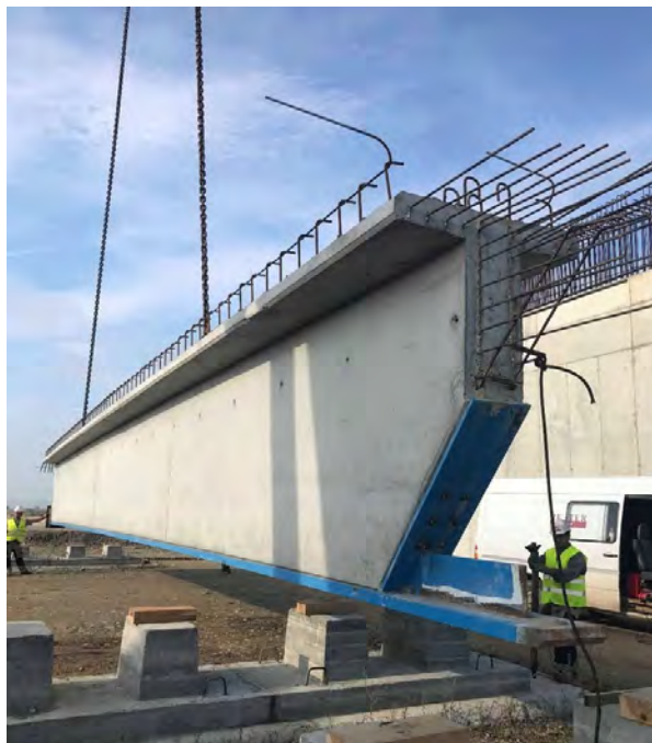
Abbildung 35: Trägerhälfte des Verbundfertigteils auf der Baustelle
