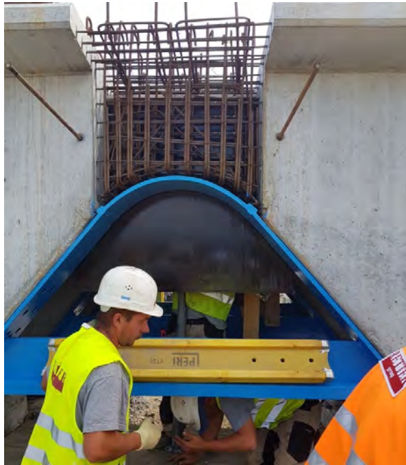
Abbildung 36: Vorbereiteter Trägerstoß
