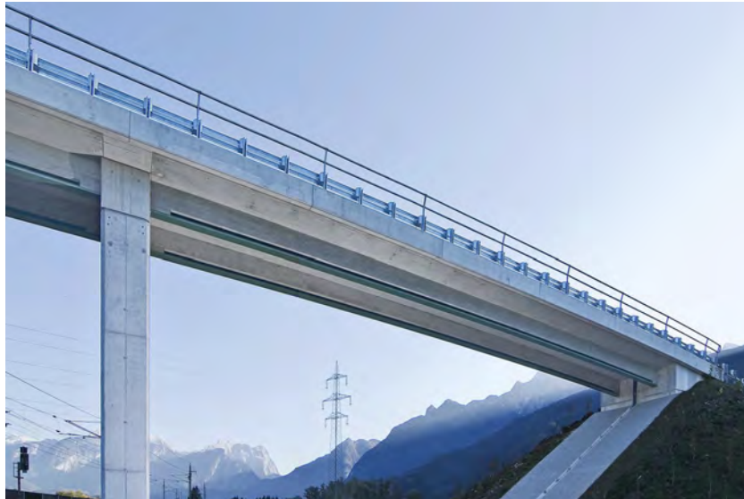
Abbildung 8: Untersicht der Brücke in Vigaun (A)
