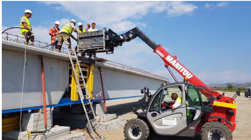
Abbildung 37: Betonieren des Trägerstoßes
