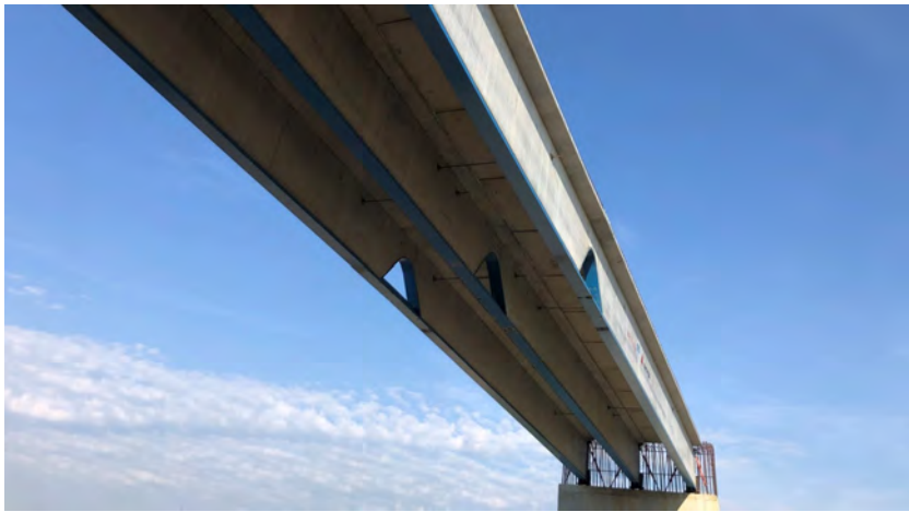
Abbildung 38: Verlegte Träger (Ü-Bauwerk)
