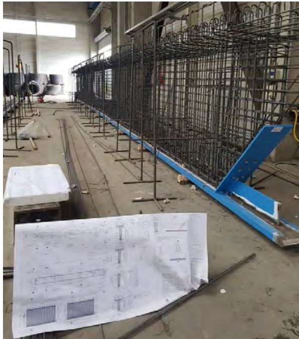
Abbildung 34: Bewehrte Stahlträgerhälfte vor dem Einheben in die Systemschalung
