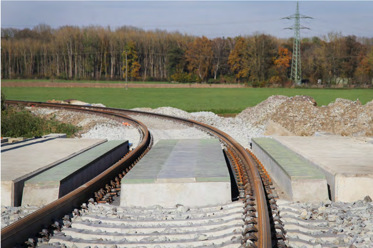
Abbildung 17: Fertiggestellte VFT-Rail-Brücke bei Langenbach/Obb. mit einem Gleisradius von 300m
