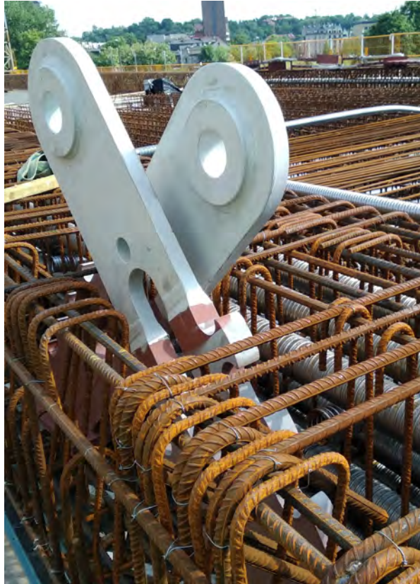
Abbildung 23: Verankerung der Hänger im Fahrbahndeck mit Verbunddübelleisten
