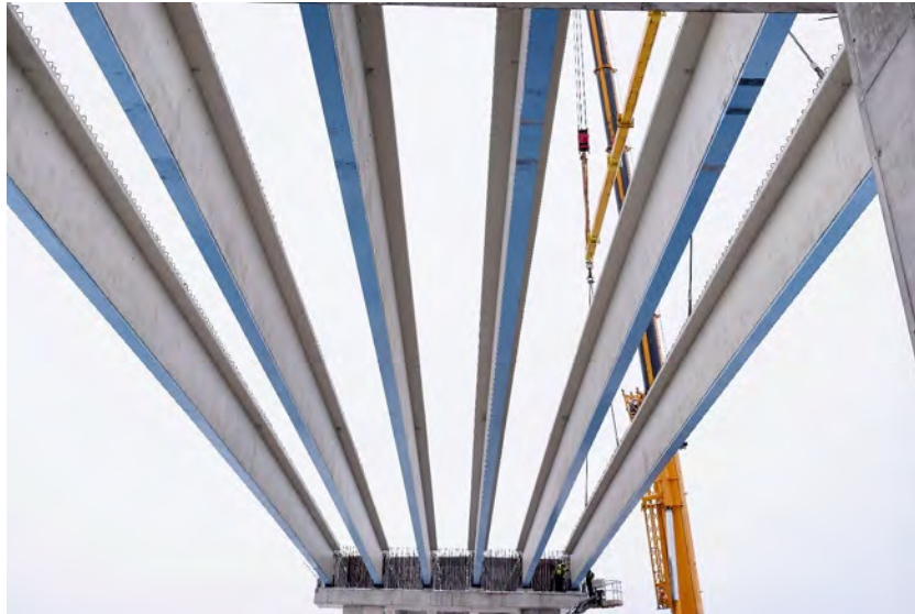
Abbildung 31: Verlegten der vorgespannten VFT-WIB-Träger
