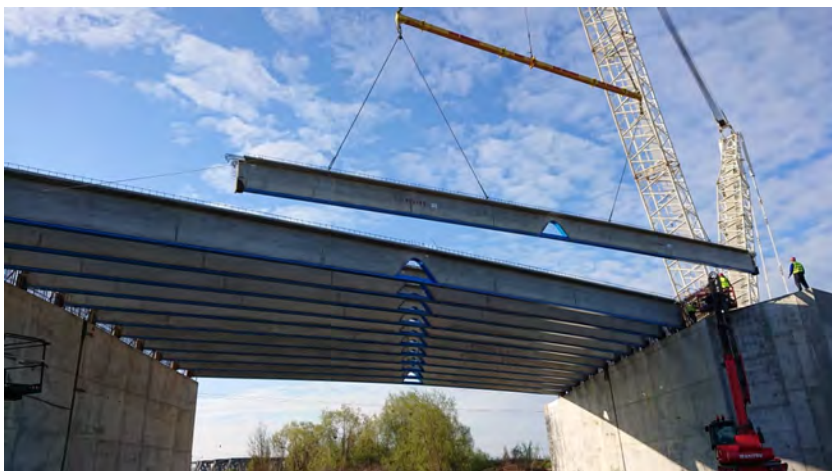
Abbildung 39: Verlegte Träger (A-Bauwerk)
