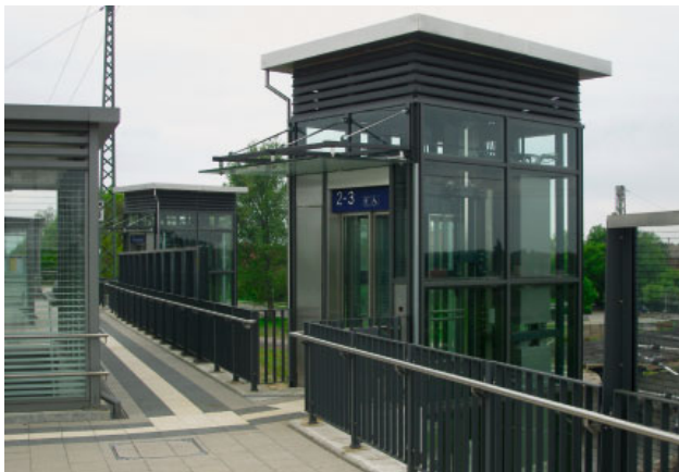
Kreuzungsbauwerk mit Bahnsteigbrücken, Zugangsbauwerken und Aufzügen
