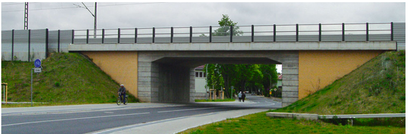
Bild unten: Eisenbahnüberführung Liebenwerdaer Straße
