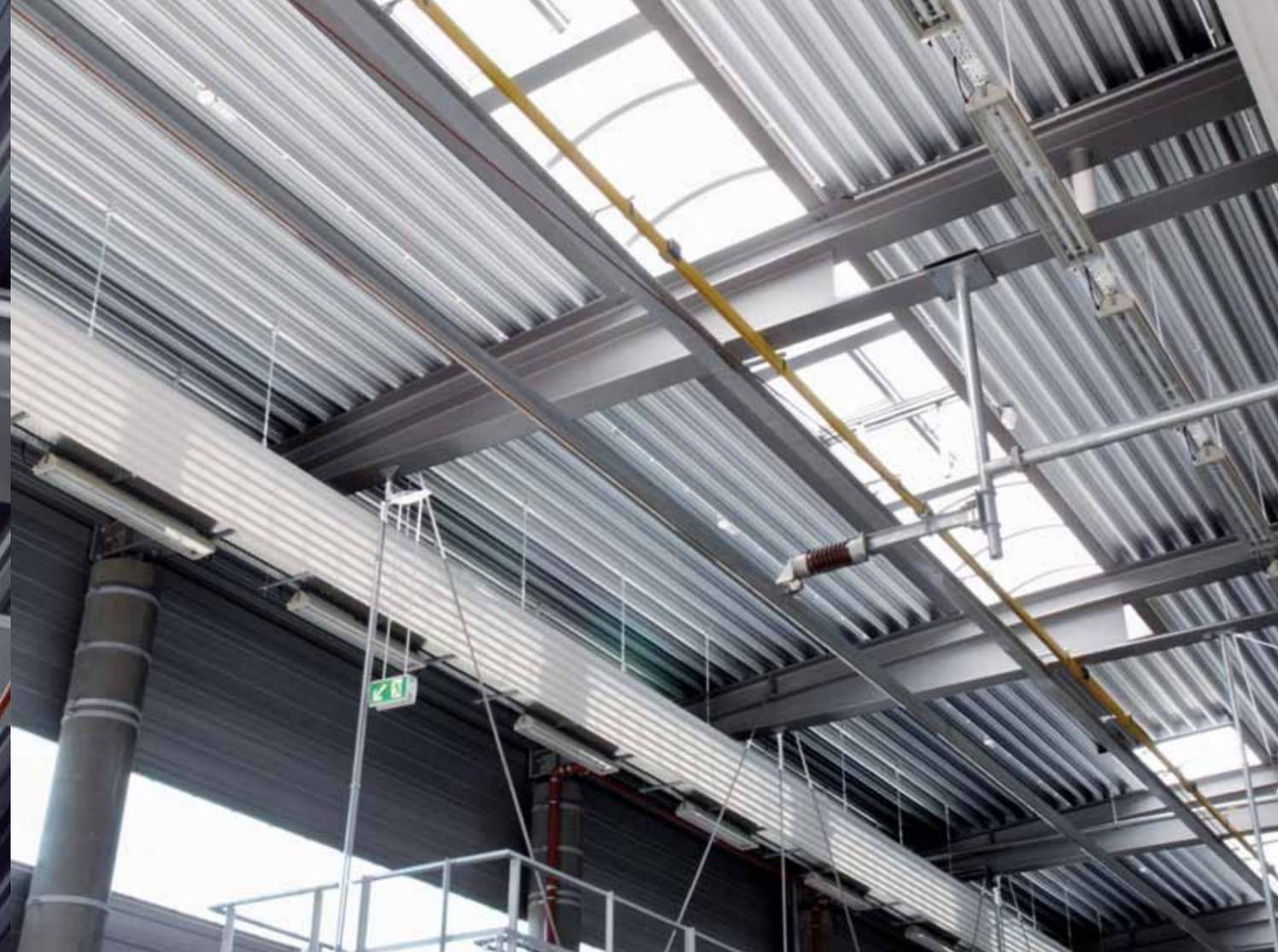
Dachtragwerk mit abgehängten Arbeitsbühnen und Fahrstromanlage
