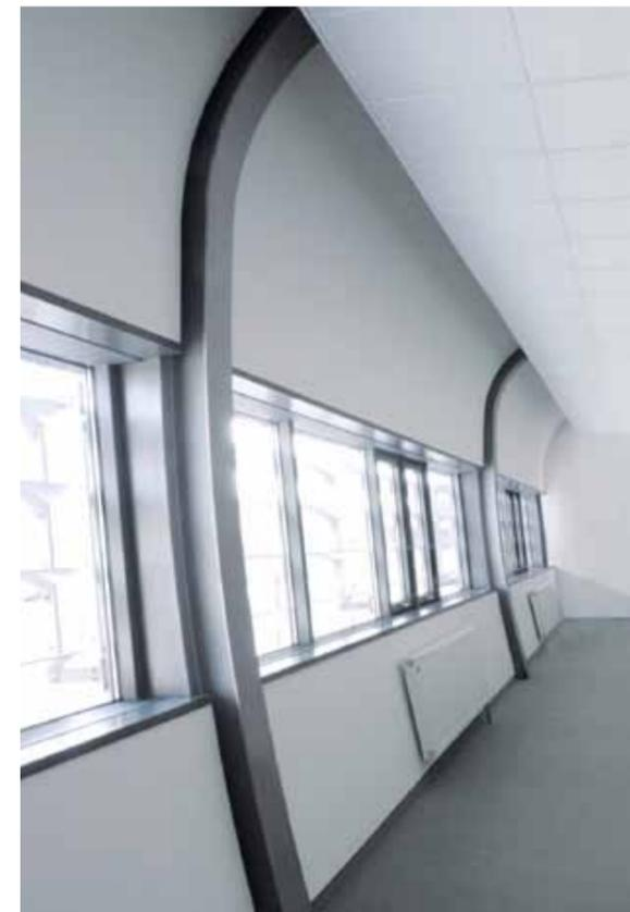
Klappflügel Fensterkonstruktion Einbau in geneigter Pfosten-Riegel Fassade
