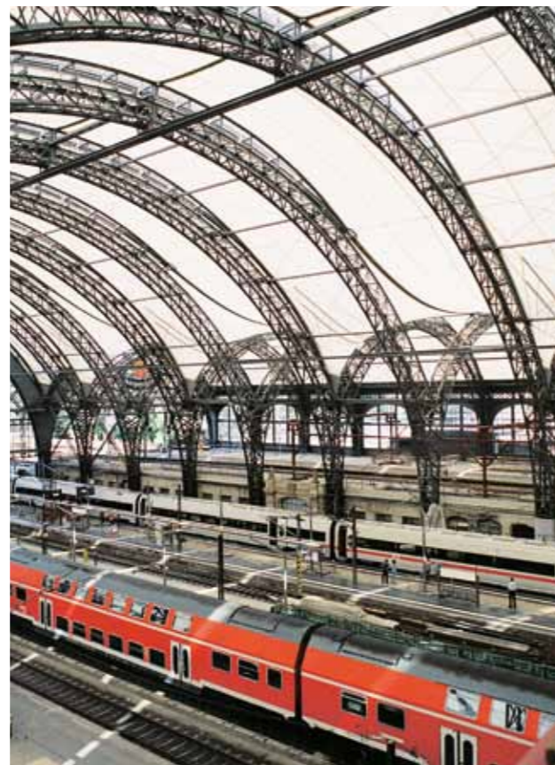
Innenansicht Mittelhalle – 10-m-Regelfelder
