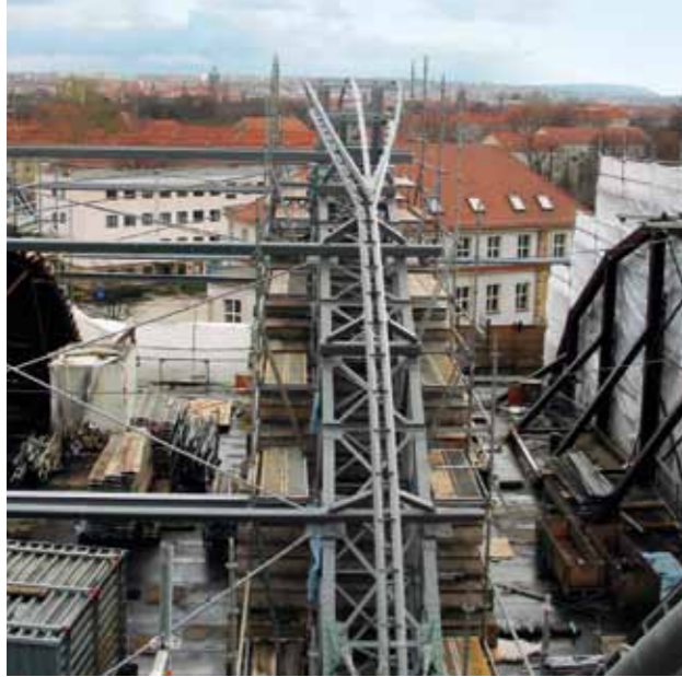
Mittelhallenbogen mit Sekundärtragwerk
