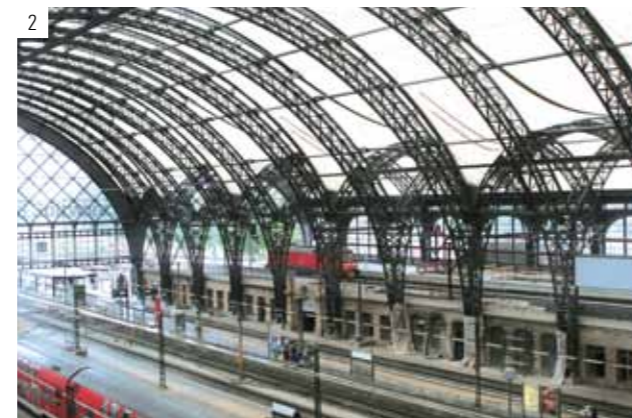
2 Innenansicht Mittelhalle mit Nordhalle – Innenfassade 4 Bauzustand Sekundärtragwerk mit Stützbogen – 14-m-Feld
