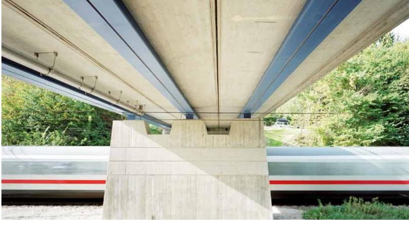
Nach dem Transport zum Fertigteilwerk werden die Stahlträger bewehrt und in einer gängigen Schalungseinheit für Spannbetonträger betoniert. Nach einer definierten Liegezeit werden die VFT-WIB-Träger zum Einbauort transportiert und Flansch an Flansch auf die Unterbauten verlegt. Anschließend wird die Ortbetonplatte ohne zusätzlichen Schalungsaufwand bewehrt und betoniert.
