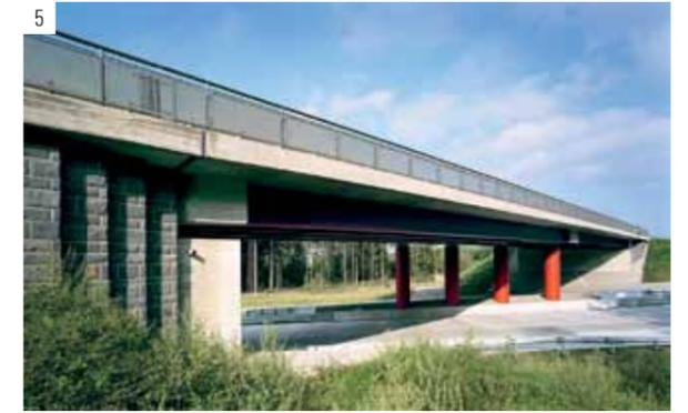
**1+2 Talbrücke Oberharthmannsreuth im Zuge der BAB A93;** Stützweiten 34,80 + 3 x 44,0 + 34,80 m; Einsatz von 2 x 2 offenen VFT-Vollschweißträgern mit einer Bauhöhe von 2,65 m, Breite Fertigteil-Obergurt 3,10 m, Einsatz Schalwagen zur Herstellung der Verbundplatte, Breite Überbau 2 x 14,68 m.
