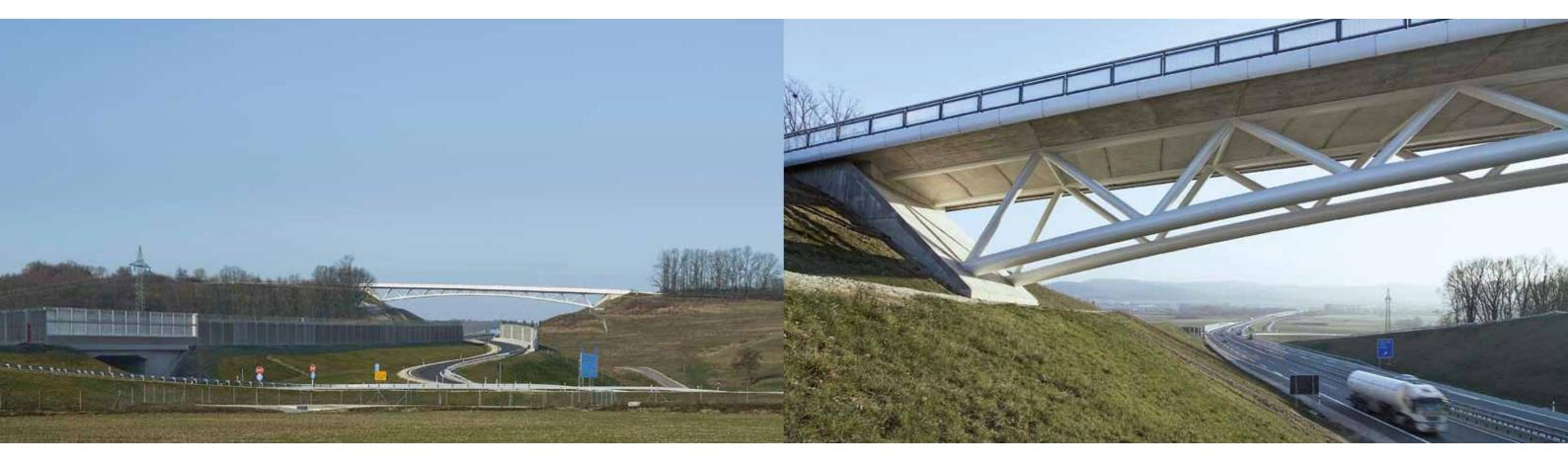
Ziel bei dem Brückenbauwerk 67-1 war es, eine Knotenform zu wählen, die im Grenzzustand der Ermüdung ein Rissbild im Bereich der für Herstellung und Prüfung gut zugänglichen vorderen Nahtbereiche in den stumpfen Winkeln erwarten ließ und somit auch dauerhaft im Unterhalt ist.
