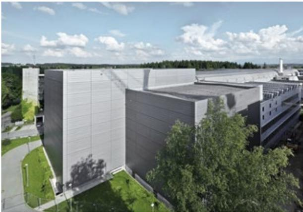
Das mit gleicher Länge anschließende Fertigungsgebäude hat einen dreieckigen Grundriss, ein Untergeschoss und zwei Obergeschosse. Wegen eines in unmittelbarer Nähe parallel verlaufenden Medienkanals wurde eine Bohrpfahlwand mit temporärer Rückverankerung errichtet. Das gesamte Bauwerk wurde als Stahlbeton-Skelettbau mit Flachdecken erstellt.
