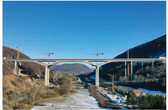
Bild 14 Fertiggestellte Brücke Final bridge after completion
