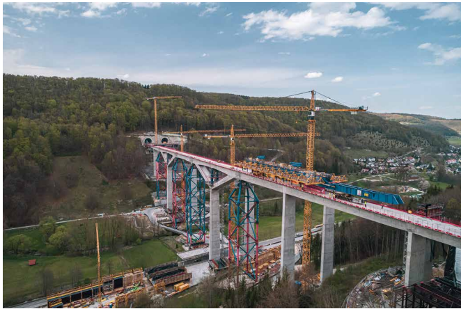
Bild 13 Zurückfahren der VSR mit SPMT Backwards moving of launching truss
