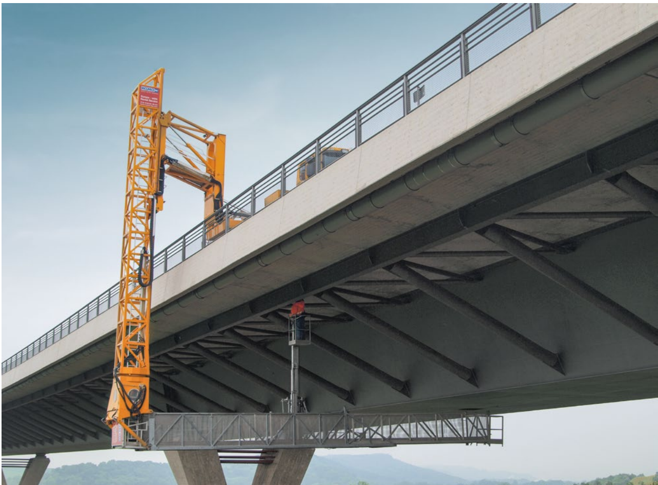
A 38, THYRATALBRÜCKE , mit 1115 m das längste Brückenbauwerk der Autobahn 38
