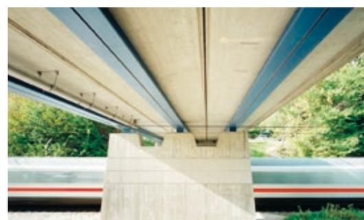
Getrennte Stahllamellen für VFT-Rail-Träger aus einem Walzprofil
