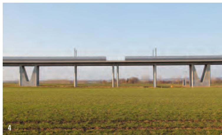
Mit unseren Erfahrungen bei der im Hause SSF entwickelten VFT®-Bauweise konnten wir diese Bauweise 2004 als Nebenentwurf für eine EÜ erstmalig in einer Hauptstrecke der DB anwenden.
