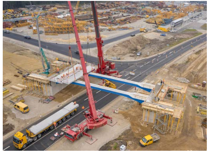
Bild 4. Blick auf die Brücke Greißelbach während der Montage der Fahrbahnelemente (Quelle Max Bögl) Fig. 4. View on the Greißelbach Bridge during the assembly of the road elements (source Max Bögl)
