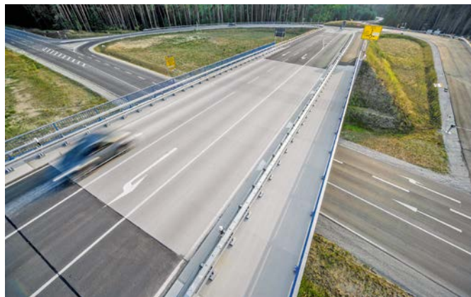
Bild 2. Brücke mit direkt befahrenen Segmenten aus der Vogelperspektive; der Übergang von der Asphalt- zur Betonfahrbahn ist gut zu erkennen (Max Bögl, Foto Reinhard Mederer)
