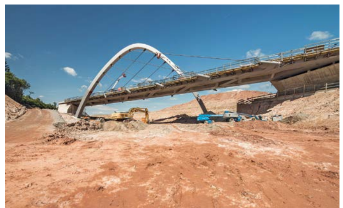
Bild 7. Monobogen in Bau Fig. 7. Mono arch under construction
