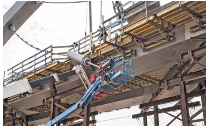
Bild 9. Seileinbau Fig. 9. Cable installation
