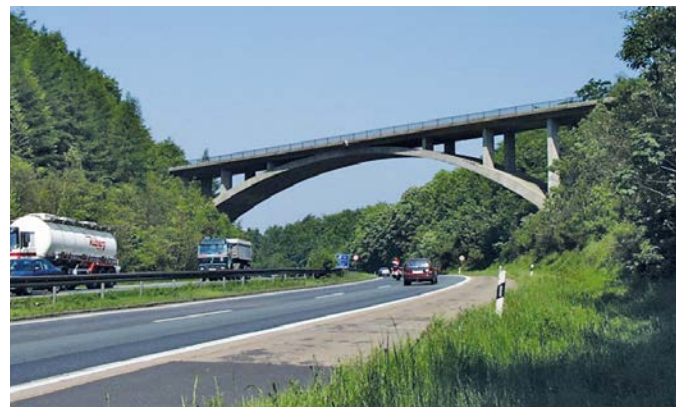
Bild 2. Blick auf die bestehende Bogenbrücke Fig. 2. View of the existing arch bridge
