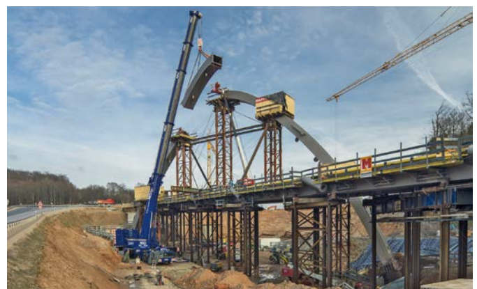
Bild 11. Bogenmontage Fig. 11. Arc assembly
