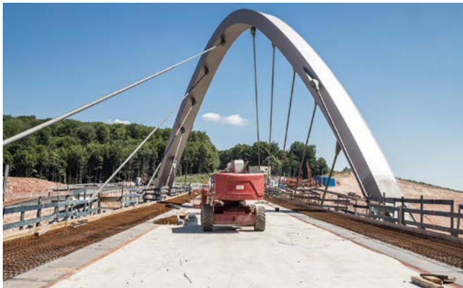
Bild 8. Monobogen im Bau Fig. 8. Mono arch under construction
