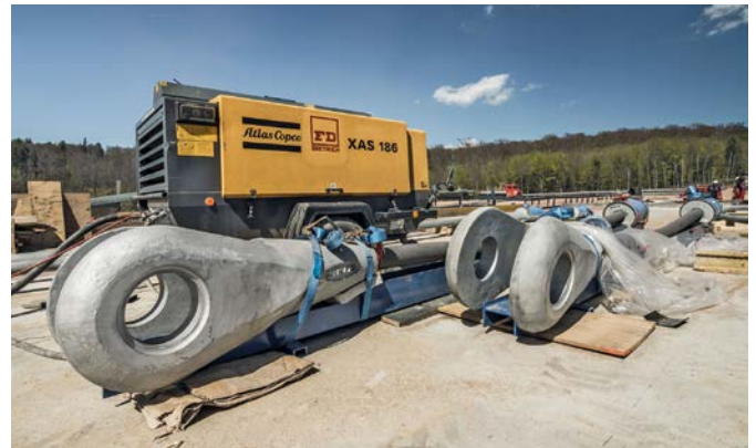
Bild 10. Seilköpfe Fig. 10. Cable heads
