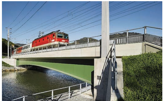
Bild 8. Die Bahnbrücke über die Salzach unter Verkehr (Foto: Florian Schreiber/SSF Ingenieure)
