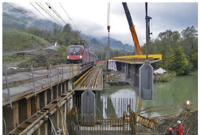
Bild 7. Einheben des zweiten, 80 t schweren VFT-Trägers in Gleis 2 (Foto: Peter Enzinger)
