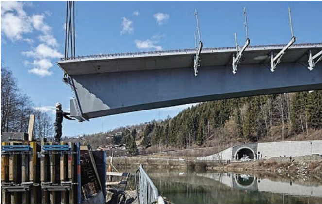
Bild 9. Einheben des 80 t schweren VFT-Hohlkastens (Foto: Florian Schreiber/SSF Ingenieure)
