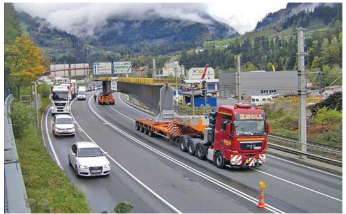
Bild 6. Transport des 45 m langen und 3,50 m hohen VFT-Trägers zur Baustelle (Foto: Peter Enzinger)
